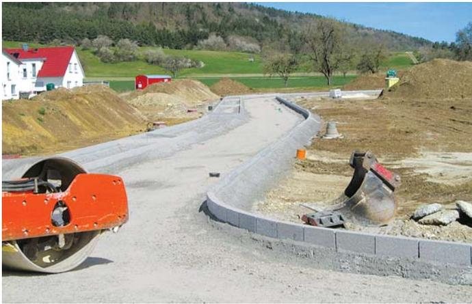
**Erschließung Baugebiet Guuhaslen Bauabschnitt II:** Unterirdische Arbeiten für Versorgungs- und Entsorgungsleitungen wurden bereits 2014 abgeschlossen. Bei der Fortsetzung der Arbeiten wurden im vergangenen Jahr die Straßenarbeiten begonnen. Im Zuge dessen wurden Randsteine gesetzt, Pflaster und Asphaltbelag gelegt sowie Straßenbeleuchtungen installiert.
